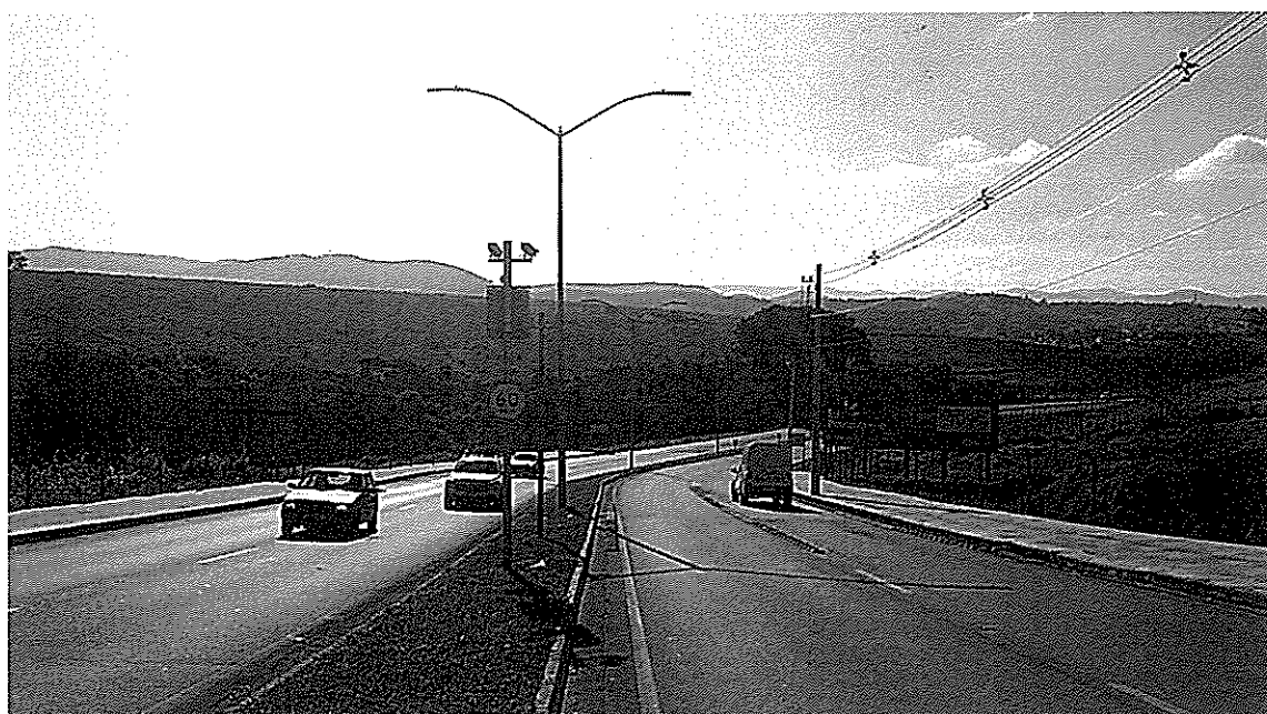
Local Fiscalizado Bairro - Centro
