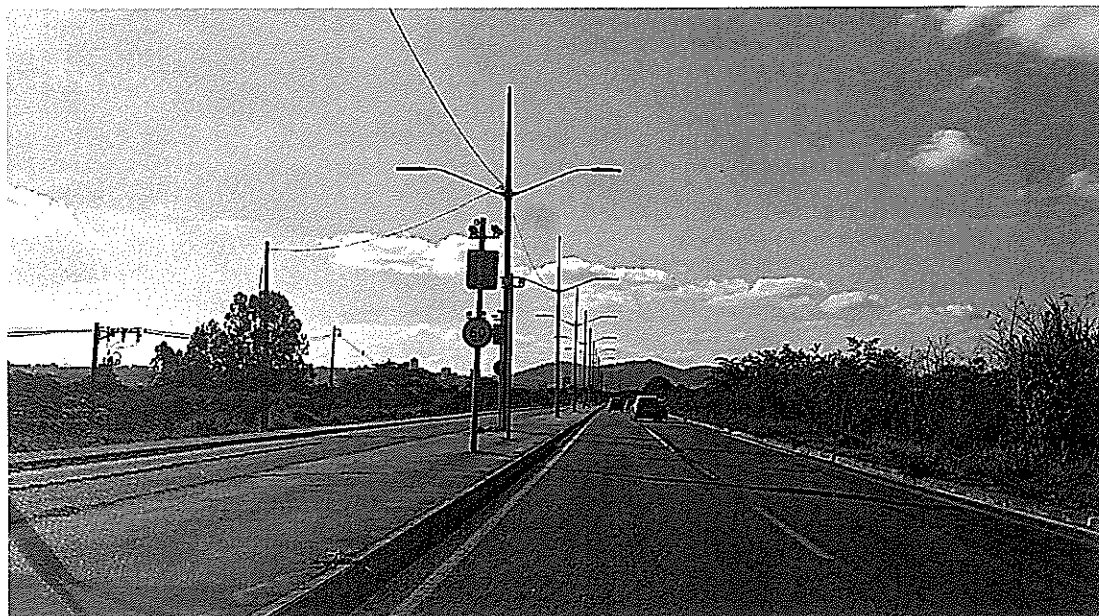
Local Fiscalizado Bairro - Centro
