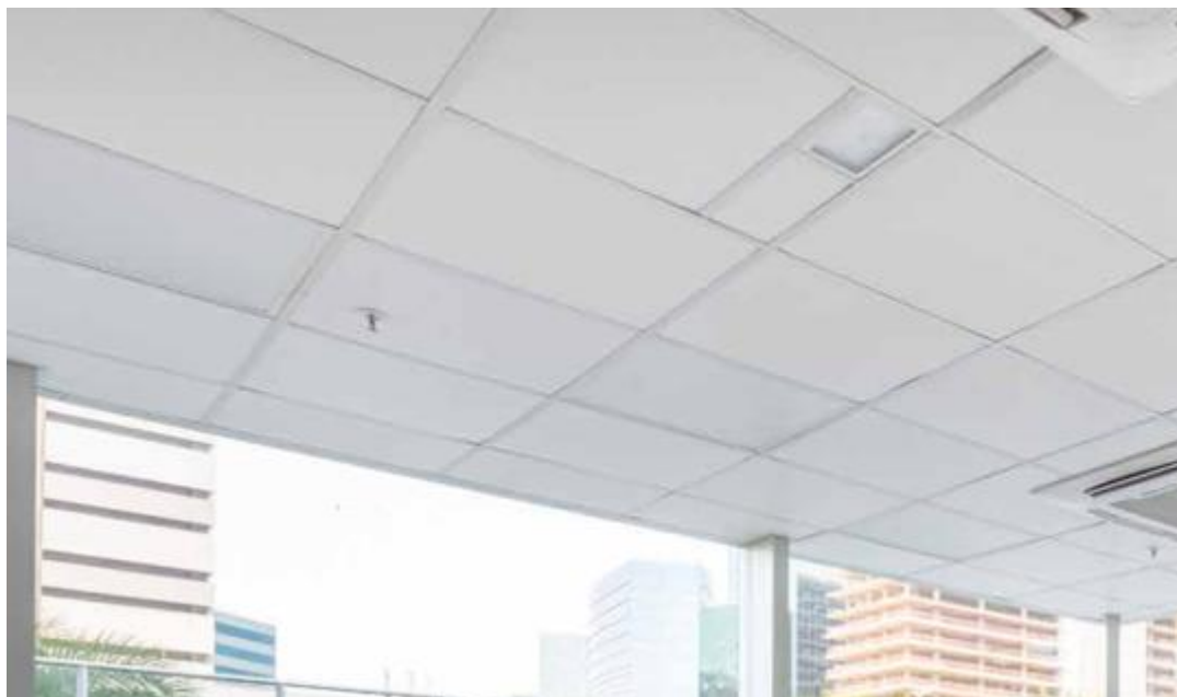
Figura 9-1 – Exemplo de aplicação de forro de fibra mineral
