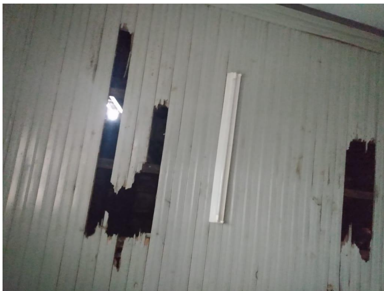
Figura 5 - Forros em madeira a serem substituídos
