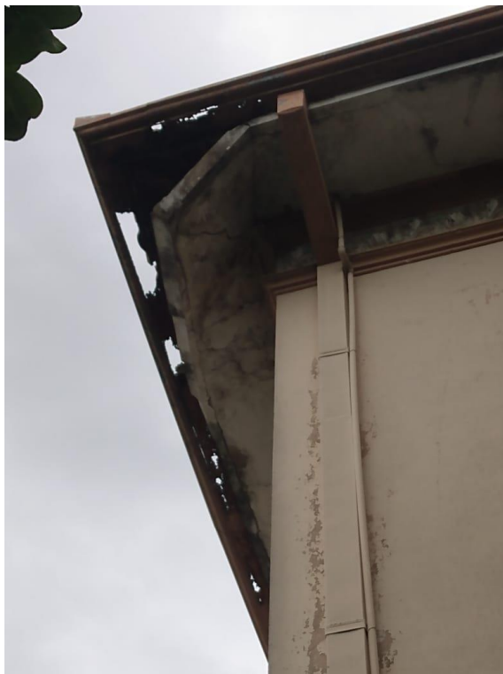
Figura 9 - Estuque a ser reformado
