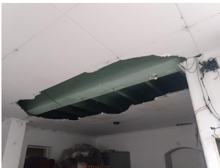
Figura 6 - Forro em placas de gesso a serem substituídos
